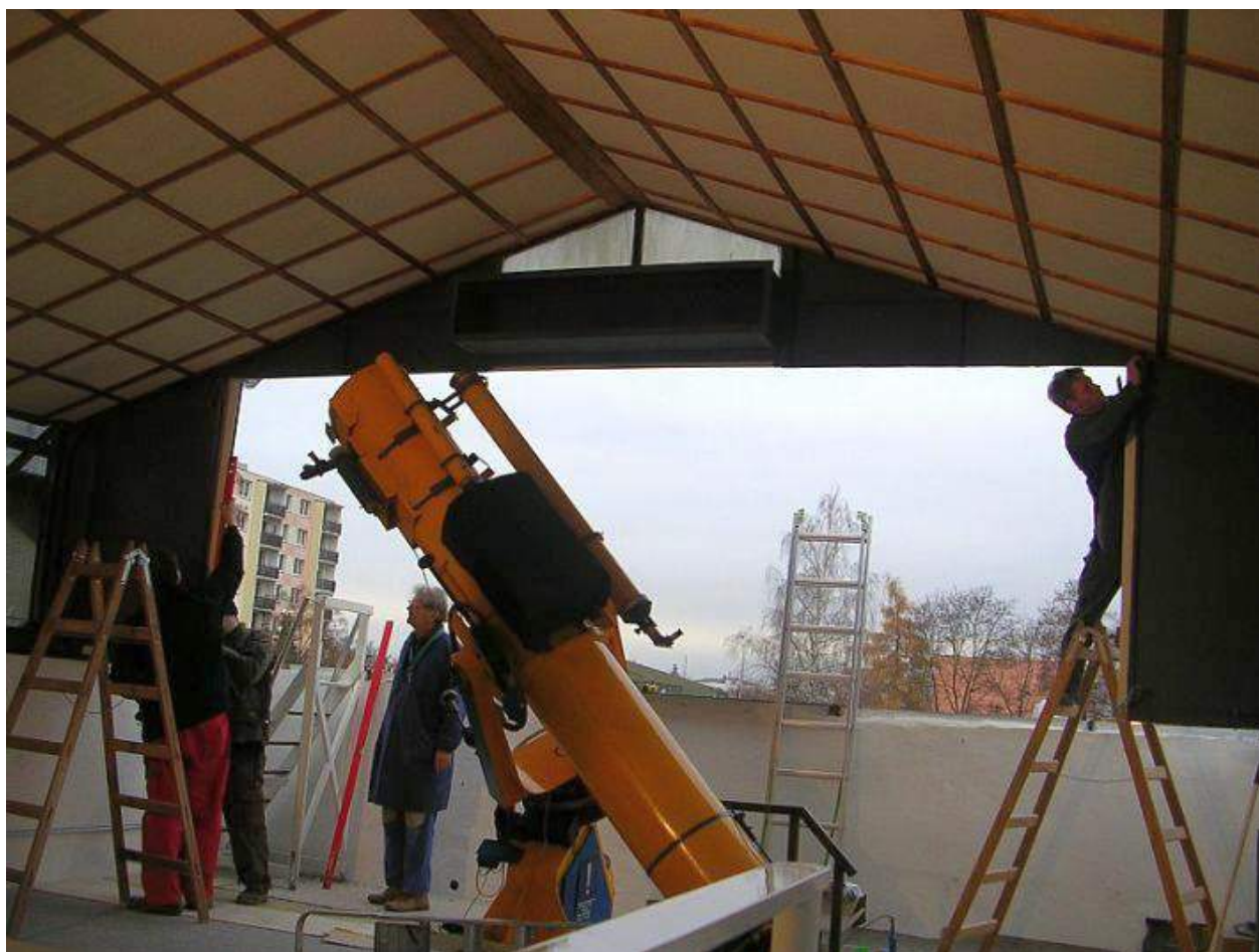
Úprava posuvné střechy pozorovatelny astronomického oddělení – hvězdárny
